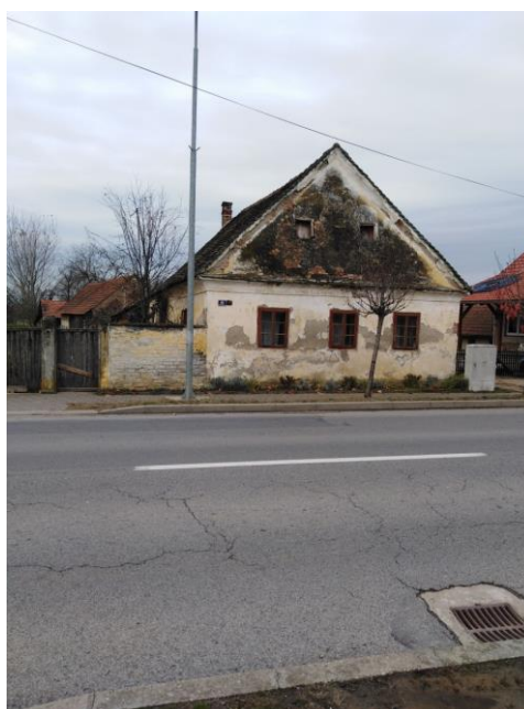
Slika broj 10.: Pročelje stambene tradicijske građevine u Molvama, Virovska ulica broj 40.
